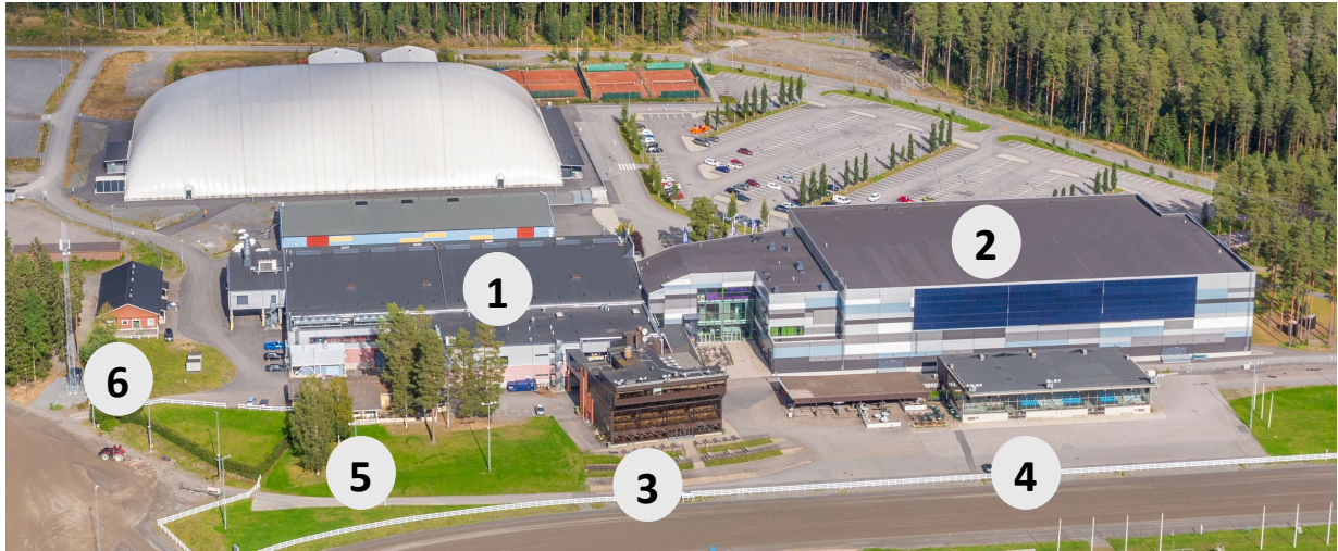
KUVA 3 Suunnittelualan rakennuksia kuvattuna lännestä.
